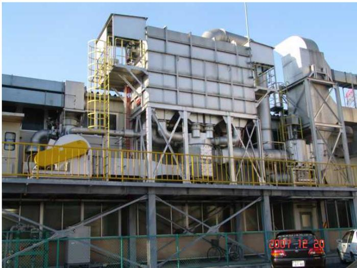
蓄熱式溶剤排ガス燃焼装置
